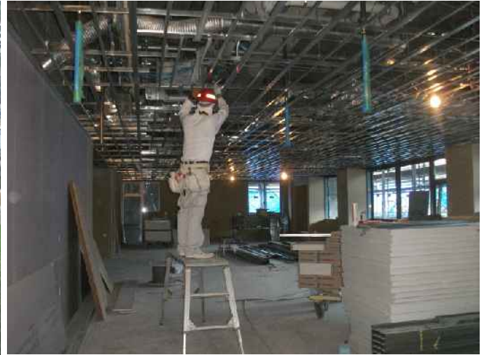
【天井下地組立】
