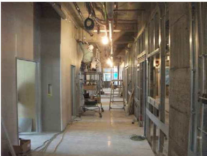
【天井設備配管取付】
